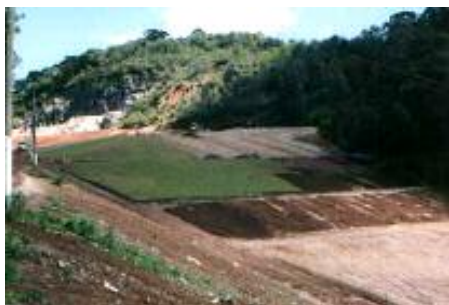
Fig. 1 - Vista lateral das células de aterramento
