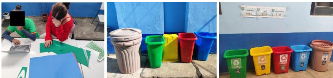
Figura 3: Construção da área de descarte de recicláveis
